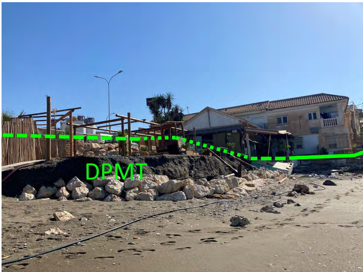
Deslinde del DPMT entre los vértices M-53 y M-56. Ocupaciones del DPMT. Efectos de un temporal
