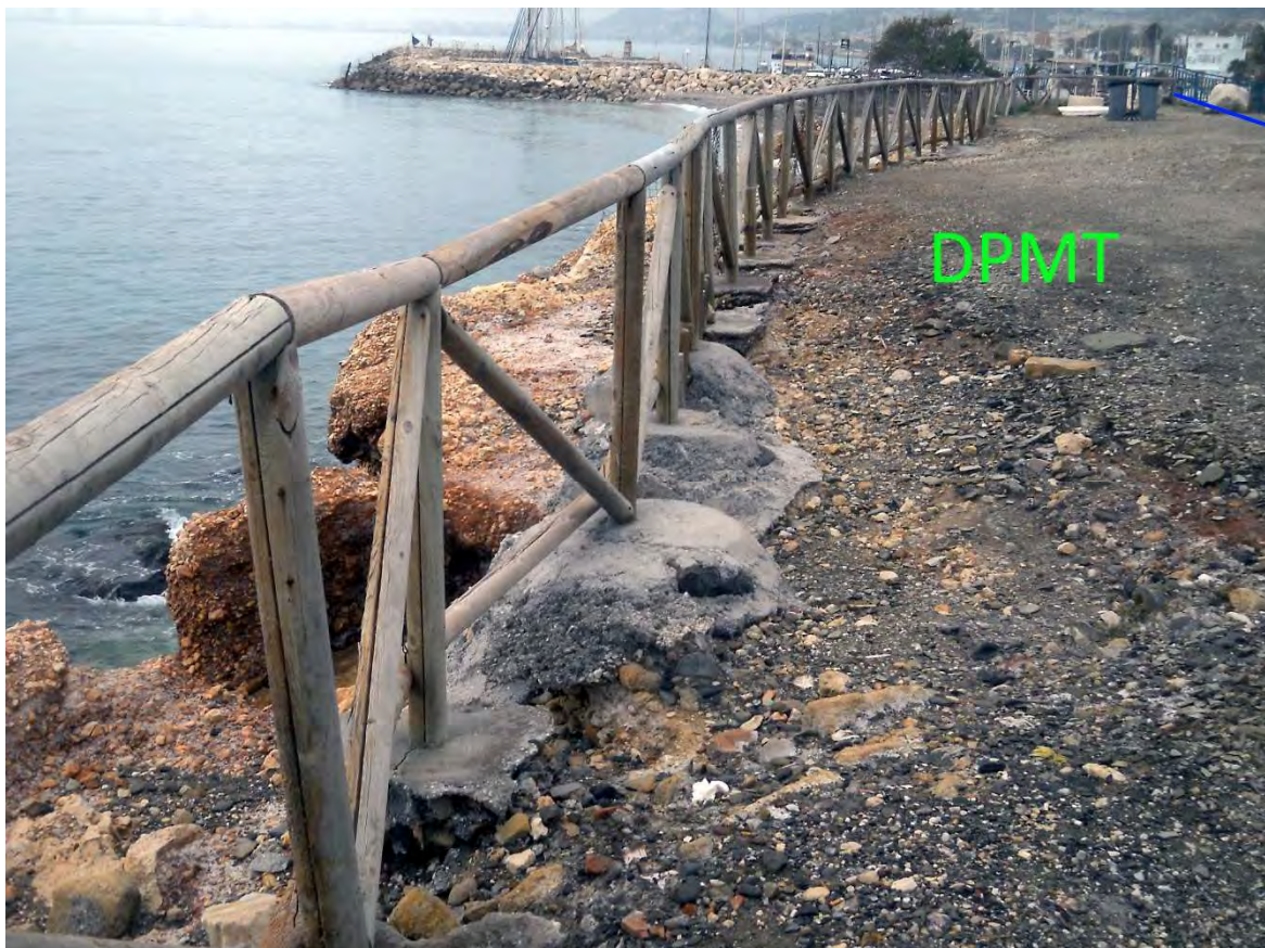
Deslinde del DPMT entre los vértices M-18 y M-19. Pérdidas de suelo por efecto del oleaje.
